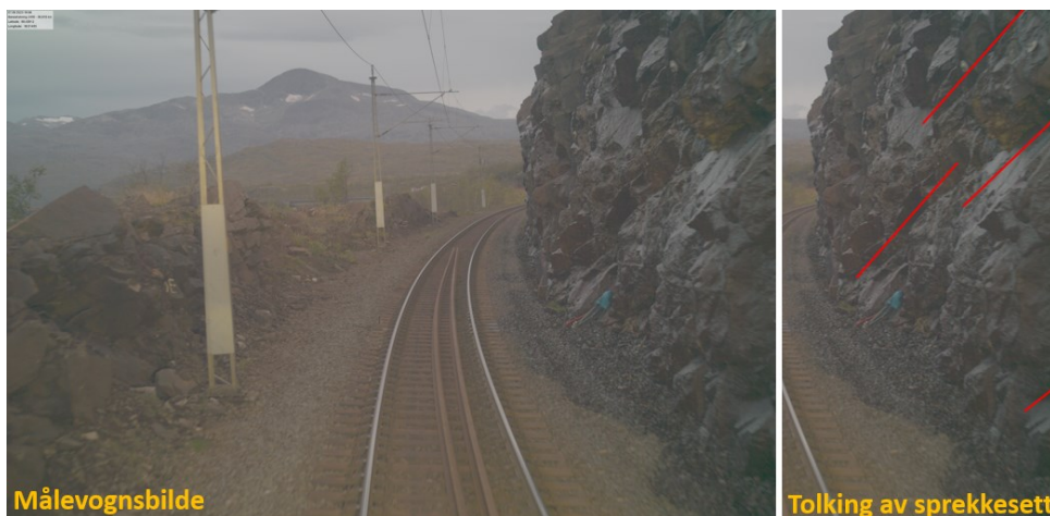
Figur 5.2 Steilt sprekkesett på omtrentlig 60 grader fra horisontalplanet.
