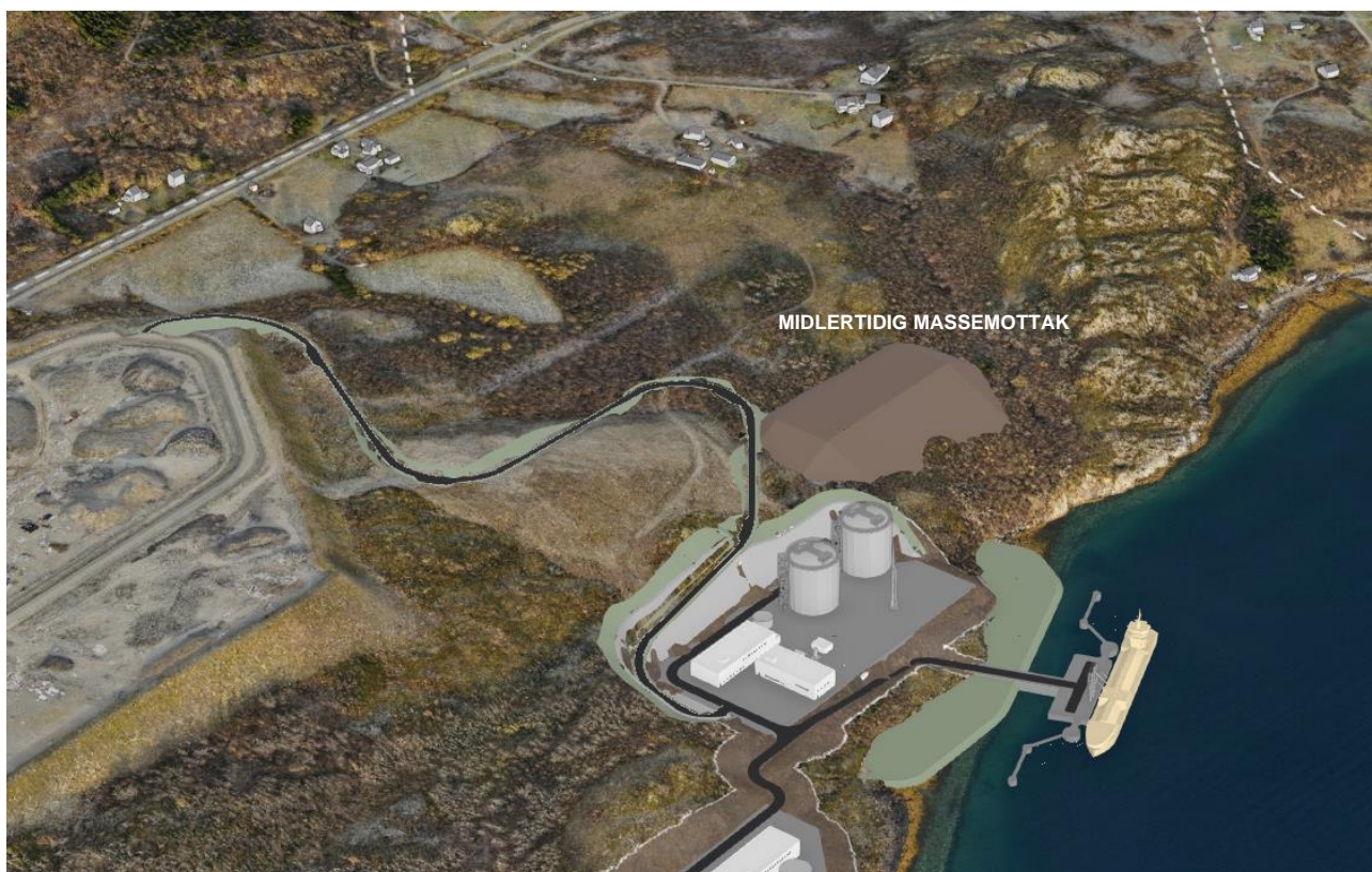
Figur 2-23: Midlertidig massemttak Lallasletta, oversiktsbilde.
