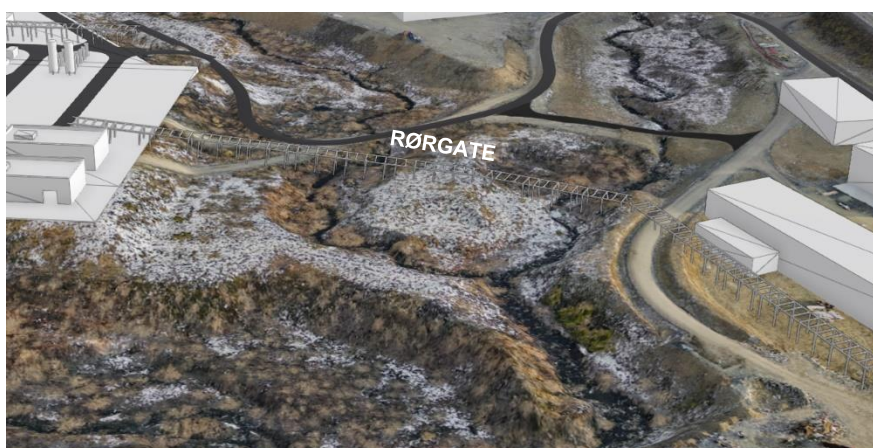
Figur 2-5: Rørgate mellom hydrogen- og ammoniakkanlegg
