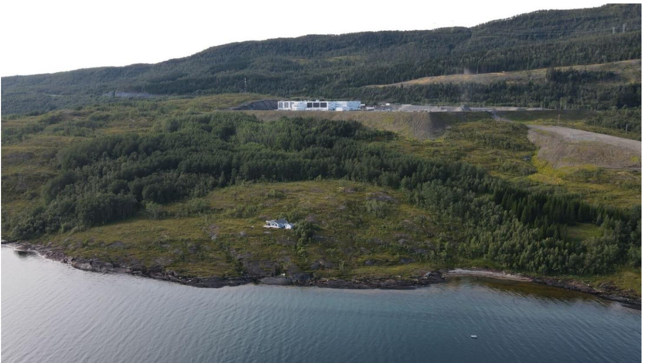
Figur 4-4: Dronefoto som viser Lallasletta med tiltaksområdet i front og etableringen av Rema 1000s distribusjonslager i bakkant. Foto: Aker Narvik.
