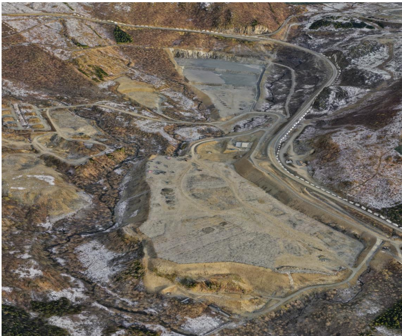
Figur 5-14: Utklipp fra 3D-modell med flyfoto overlagt ved Skoglund som viser gjennomførte grunnarbeider på områdene hvor det foreslås etablert ammoniakkanlegg, hydrogenanlegg og annen industri.
