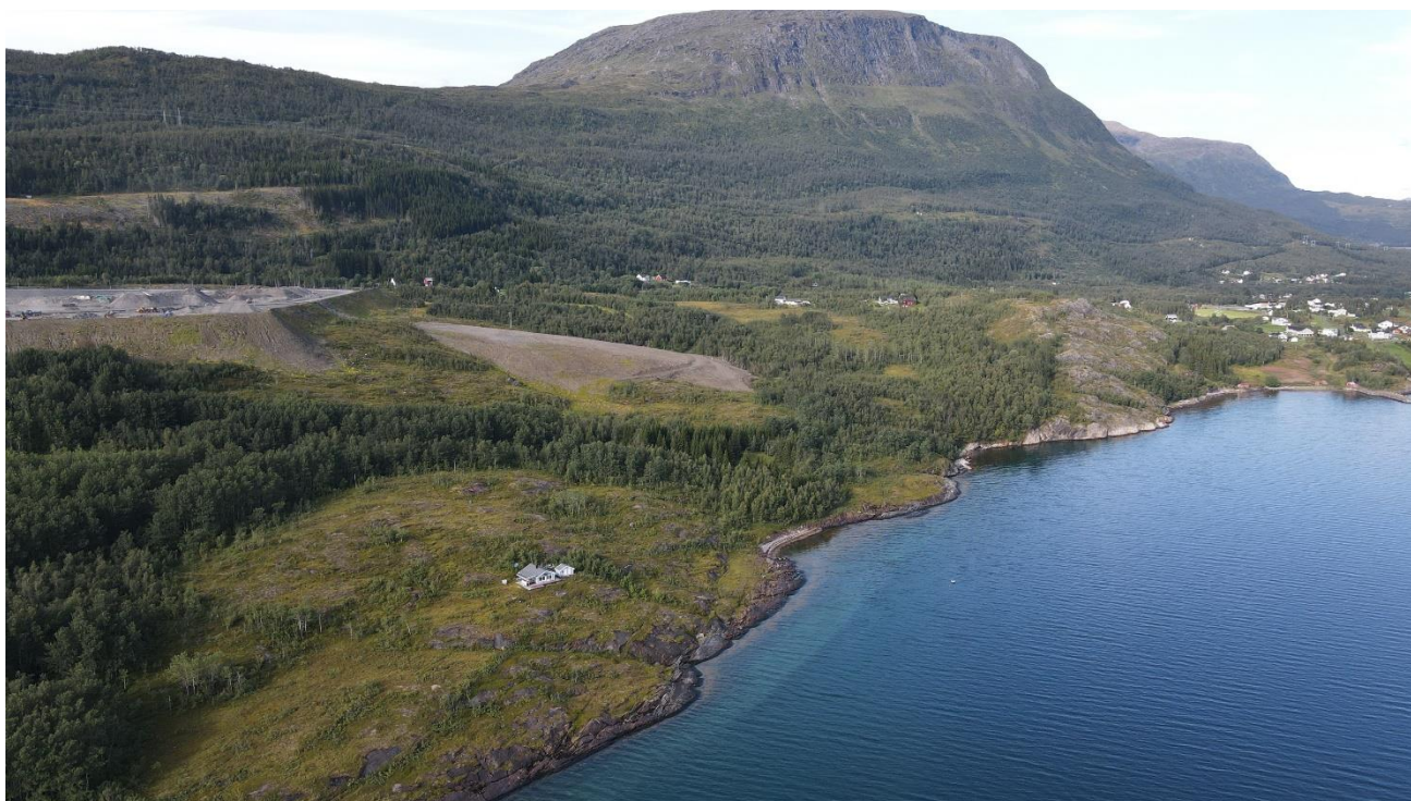
Figur 1-5: Lallasletta – dagens situasjon. Dronefoto som viser påbegynt etablering av distribusjonslager for Rema1000 i tråd med gjeldende reguleringsplan helt til venstre. Foto: Aker Narvik.
