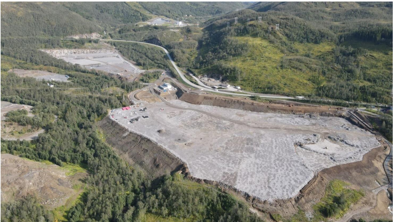
Figur 4-2: Dronefoto som viser utførte grunnarbeider ved Skoglund. Foto: Aker Narvik.
