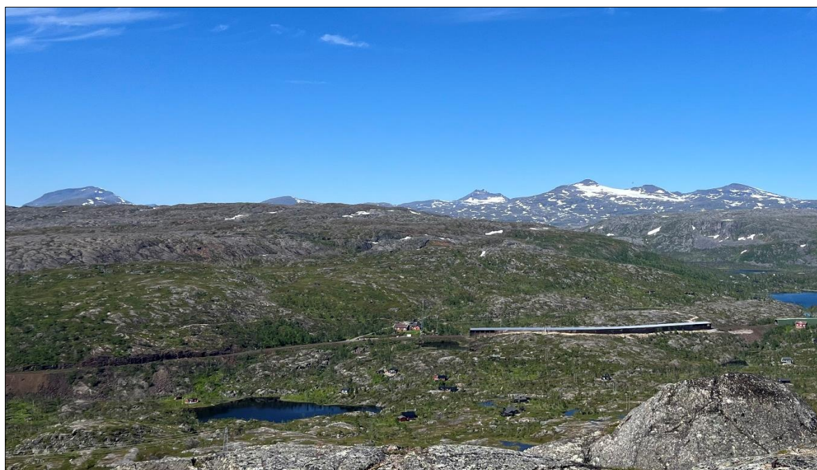
Figur 6.3: Bilde tatt fra Spionkopen. Her kan man se dagens skjæring langs jernbanesporet mellom Søsterbekk holdeplass og gamle Haugfjell stasjon. Kilde: NIRAS
