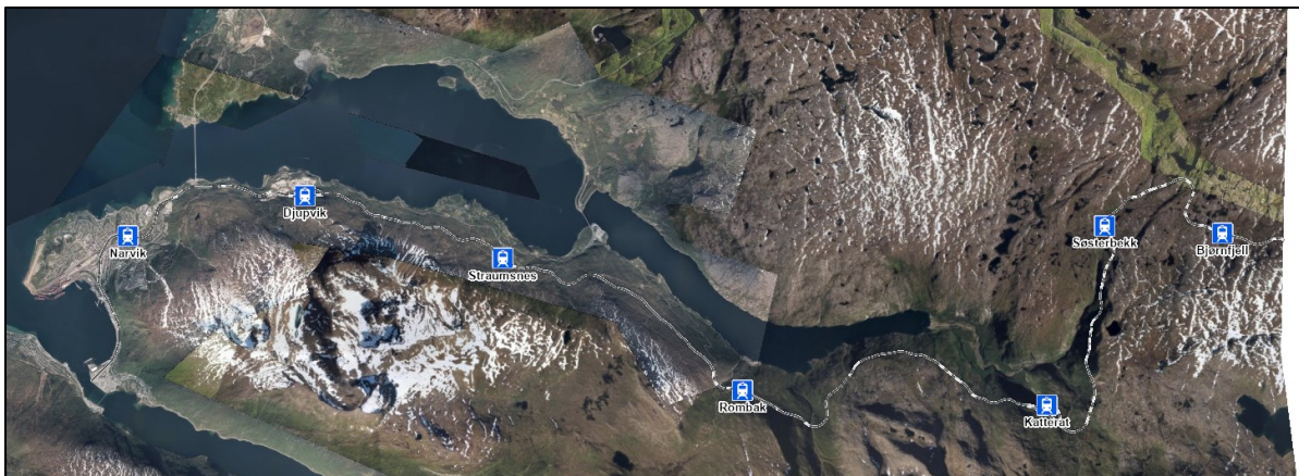
Figur 1.2: Oversiktskart Ofotbanen, Narvik Havn til Riksgrensen – Ortofoto med plassering av Søsterbekk, hentet fra Bane NORs banekart.
