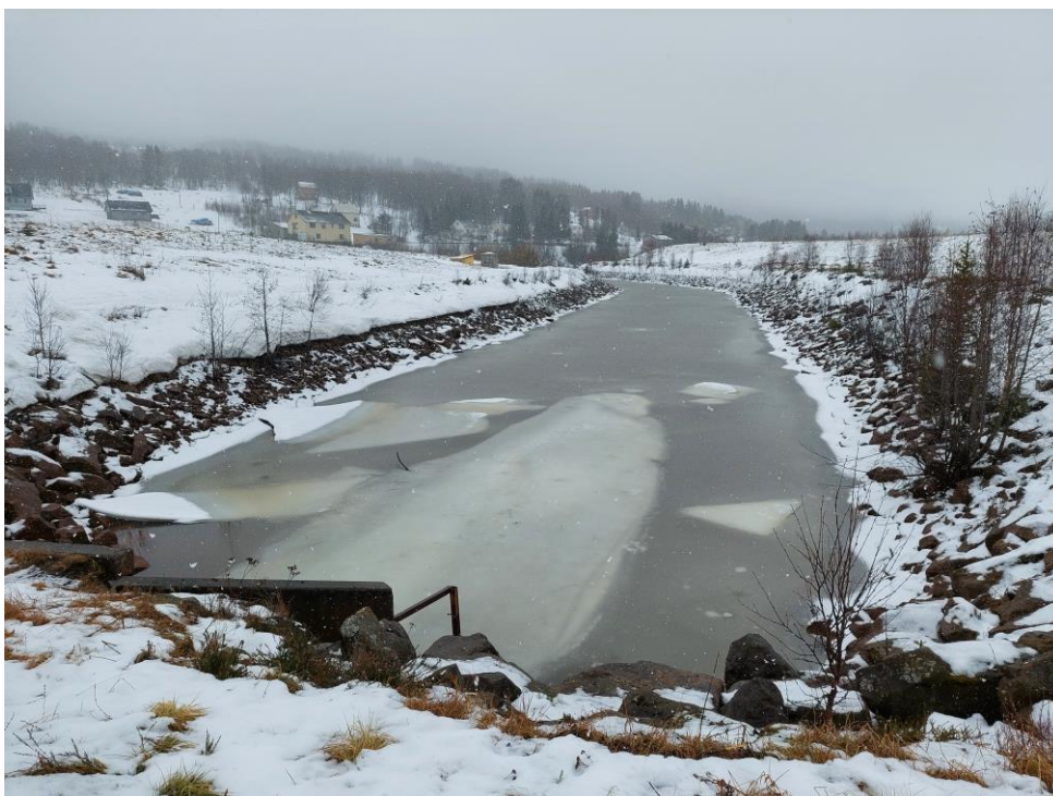
Figur 4-10: Foto fra området som viser Kiselva i sørlig retning. Steinfyllingen er synlig i kantsonen til Kiselva. Foto: Norconsult, 2022.
