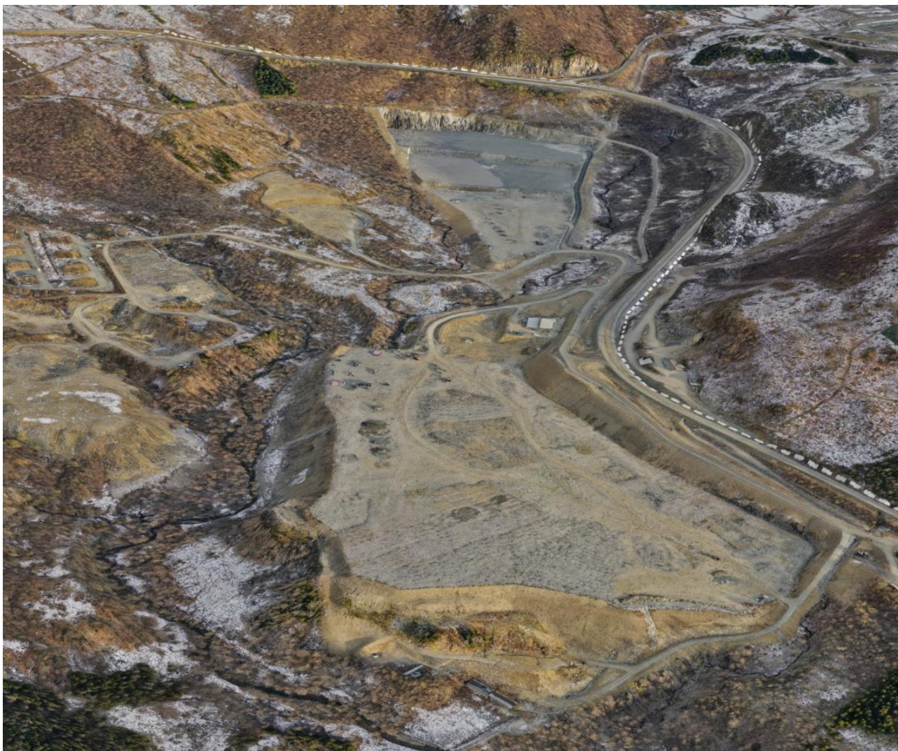
Figur 2-2: Flyfoto over Skoglund som viser gjennomførte grunnarbeider på områdene hvor det foreslås etablert ammoniakkanlegg, hydrogenanlegg og annen industri.
