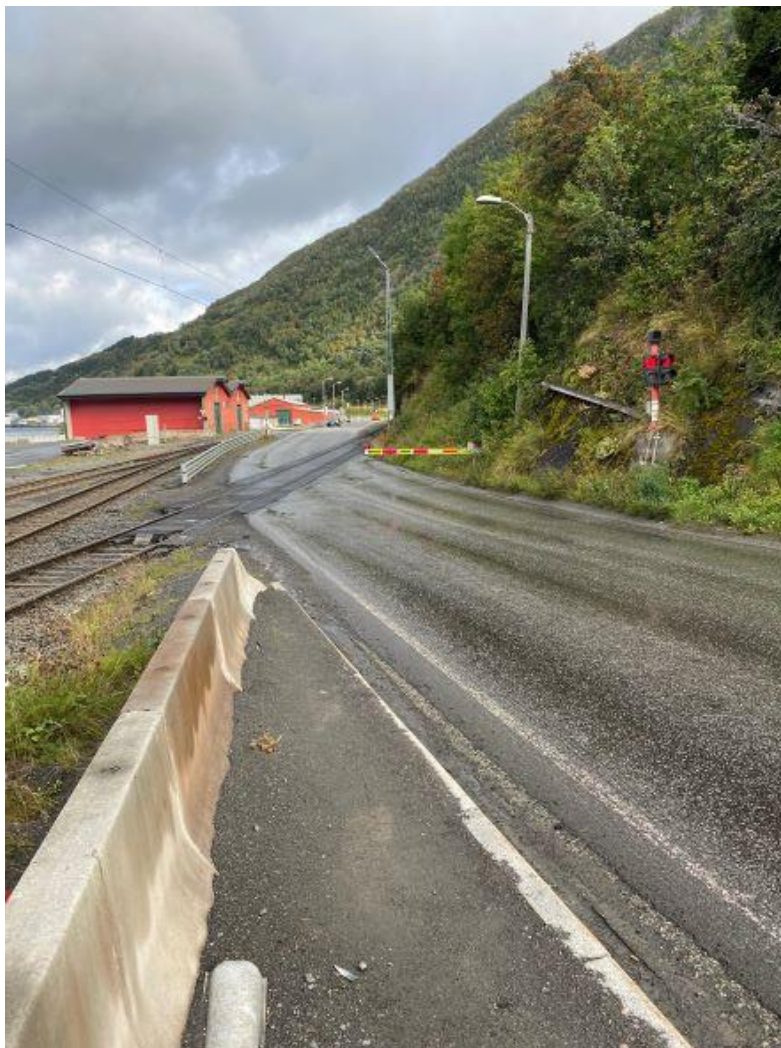
Figur 19 Kryssing mellom Fagernesveien og togsporet
