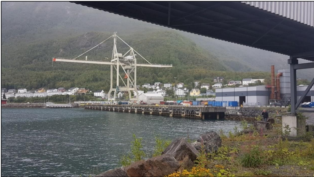
Figur 12: Narvikbuktas sjøfront langs terminalområdet på Skarveneset.
