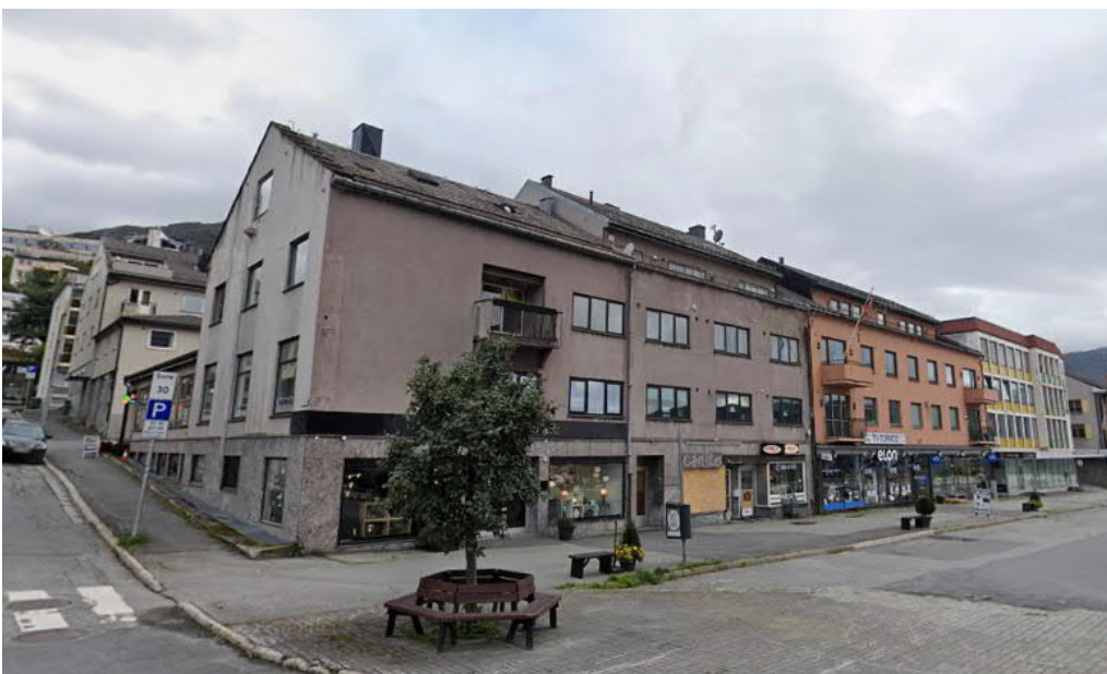
Figur 8: Eksisterende bebyggelse i Kongens gate, retning mot sørøst. Kilde: Google Maps.
