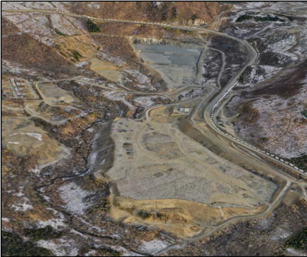
Figur 5: Flyfoto over Skoglund som viser gjennomførte grunnarbeider på områdene hvor det foreslås etablert ammoniakkanlegg, hydrogenanlegg og annen industri.
