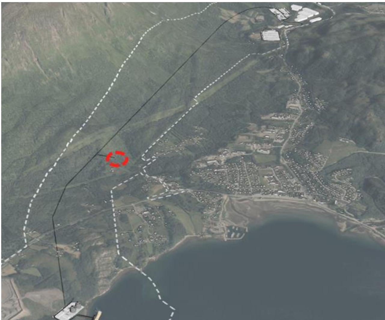
Figur 37: Figur som viser området hvor tverrslag med tilhørende riggområde (rød sirkel) planlegges etablert.
