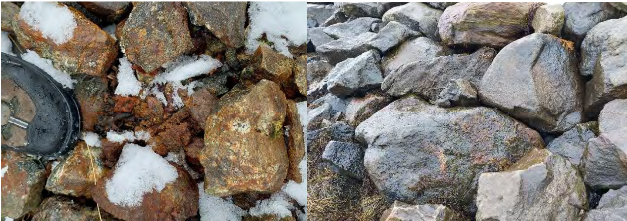
Figur 4-5: Plastringstein ved Kiselva (t.v.) og ved kaiskråning i nordvestenden av tomten (t.h.).
