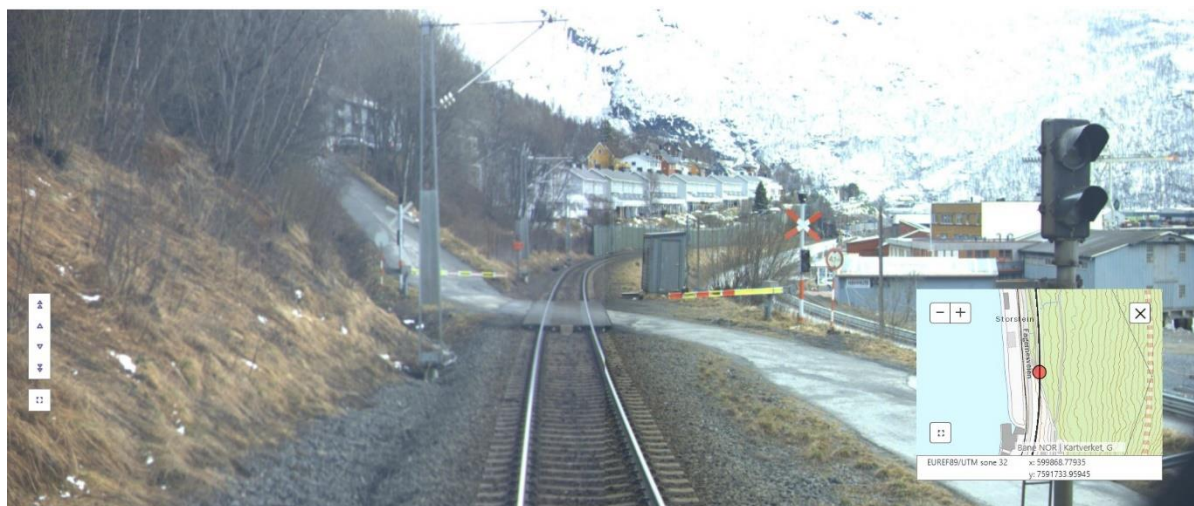
Figur 5 Fagernesskrenten PLO sett mot sør. Nedre bebyggelse langs Fagernesskrenten er rekka med hvite hus midt i bildet (målevognsfoto, Bane NOR).
