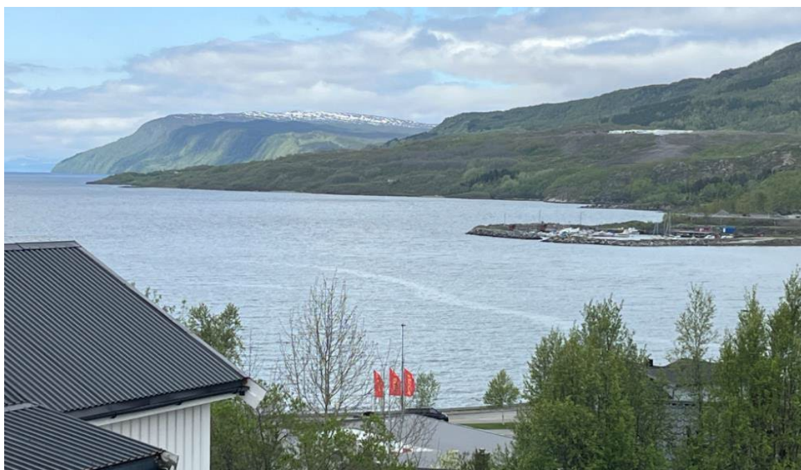
Figur 5-3 Lallasletta sett fra Bjerkvik. Det er tydelig gjort noen grep for å etablere industriområdet noe nedsenket i terrenget for å redusere synlighet fra fjorden og fra Bjerkvik. Men det lyse store bygget er fortsatt godt synlig i terrenget. Deponiet er tildekket med mørke jordmasser og derfor ikke like godt synlig fra omkringliggende landskap.
