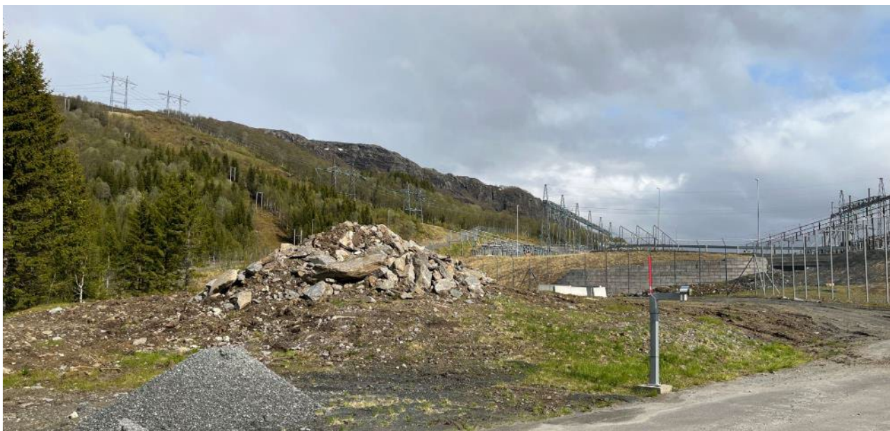
Figur 5-18 Kvanndalen transformatorstasjon inngår i delområdet
