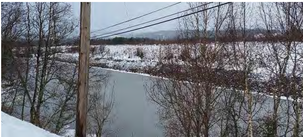
Figur 4-38: Elvebredd med plastret skråning langs den sørvestlige delen av Ballangleira.
