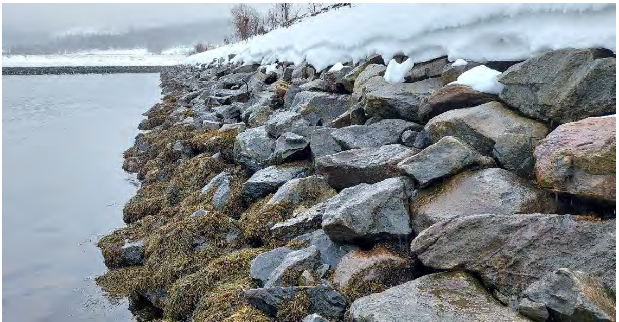
Figur 4-40: Steinsatt vannkant i det nordvestlige hjørnet av Ballangseira ved eksisterende brygge. Steinene er ca. 60 til 80 cm i diameter.
