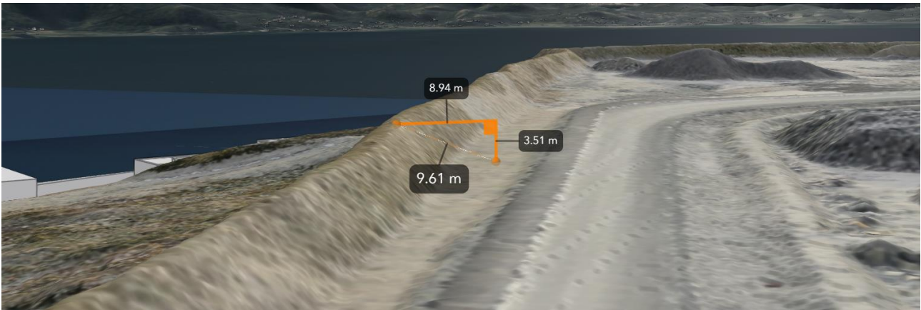
Figur 2-4 - Eksempel på etablert skjermingsvoll på Relog-tomta. Vollen er anslagsvis 3,5m høyere enn bakenforliggende terrengflate.
