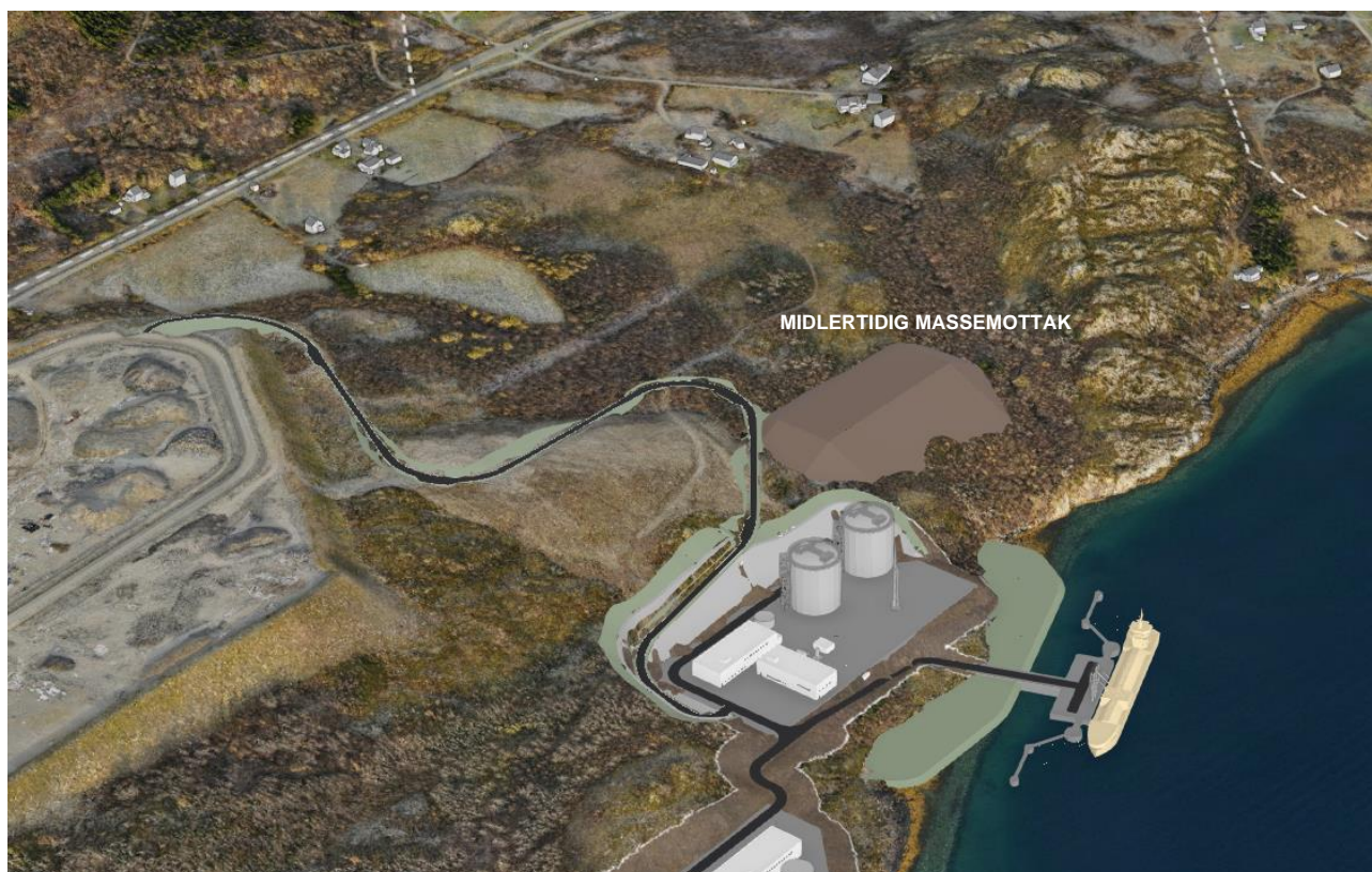
Figur 2-23: Midlertidig massemttak Lallasletta, oversiktsbilde
