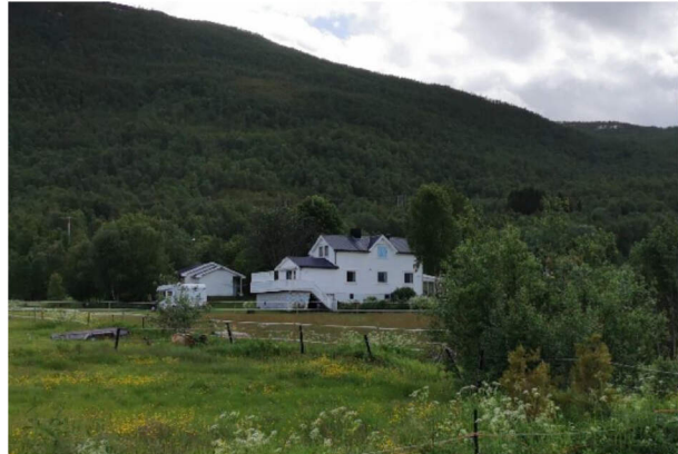
Figur 4-7: Foto tatt under befaring, bygningsmassen har vært igjennom flere endringer og har lite igjen av det opprinnelige. Foto: Norconsult.
