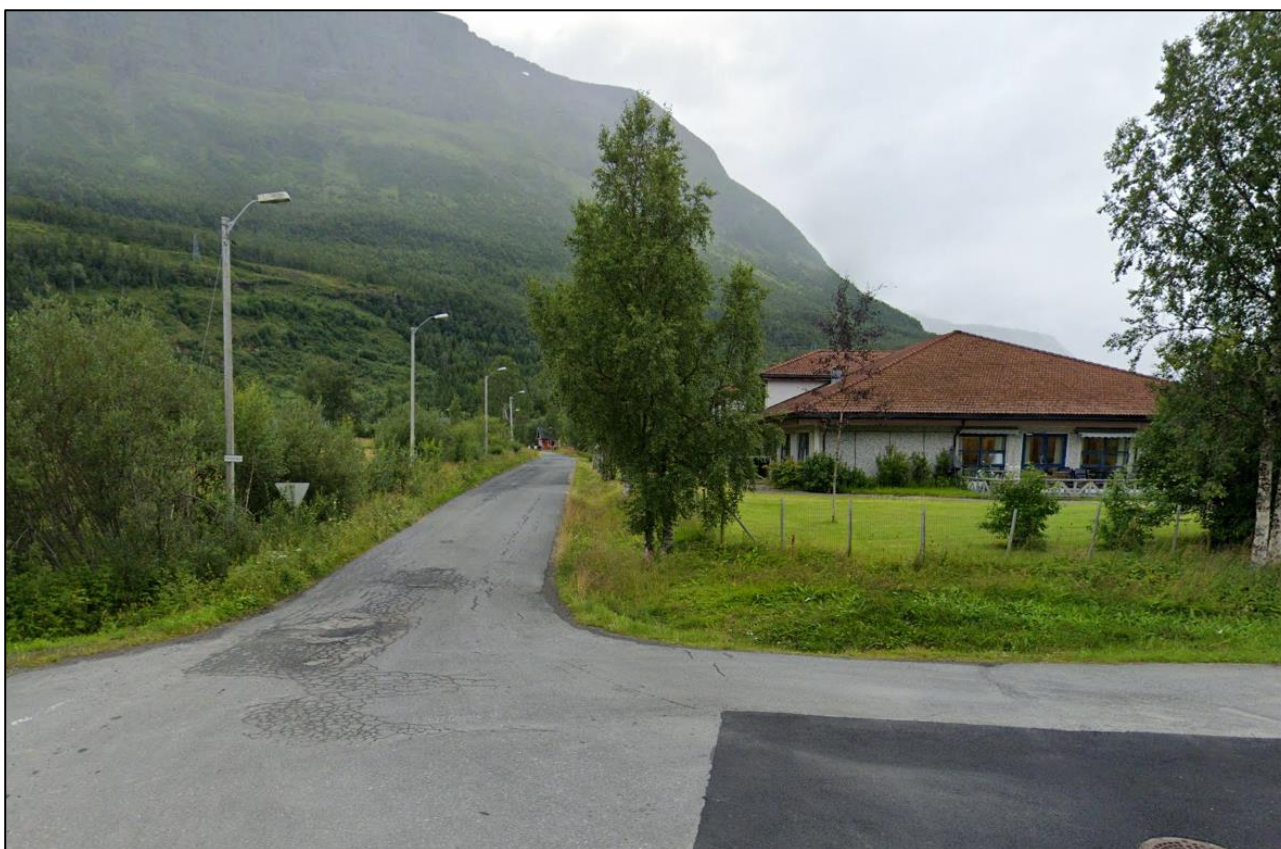
Figur 22: Prestjordvegen, sett fra krysset ved E10
