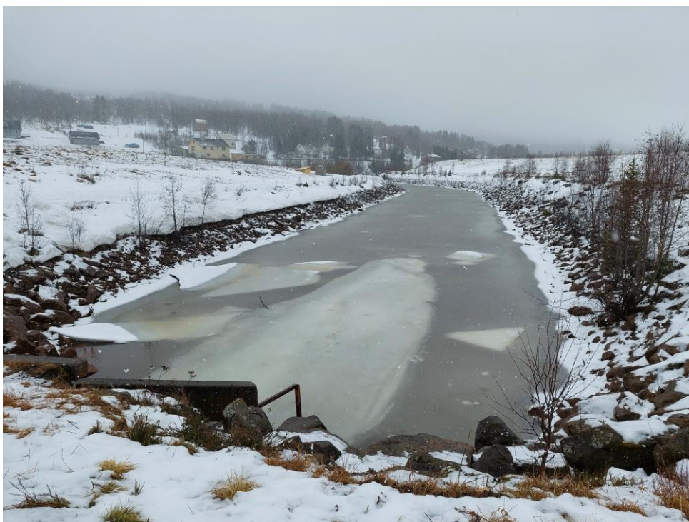
Figur 4-10: Foto fra området som viser Kiselva i sørlig retning. Steinfyllingen er synlig i kantsonen til Kiselva. Foto: Norconsult, 2022.
