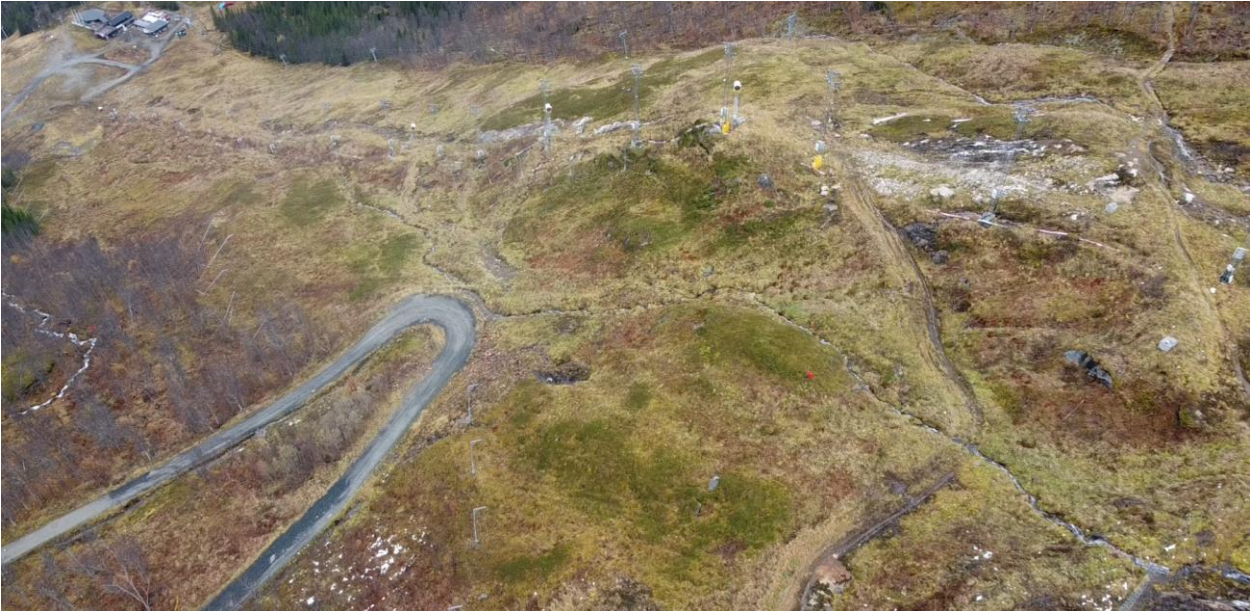
Bilde 4: Jordskred som er gått øst for heistraseen. Sett mot sør.
