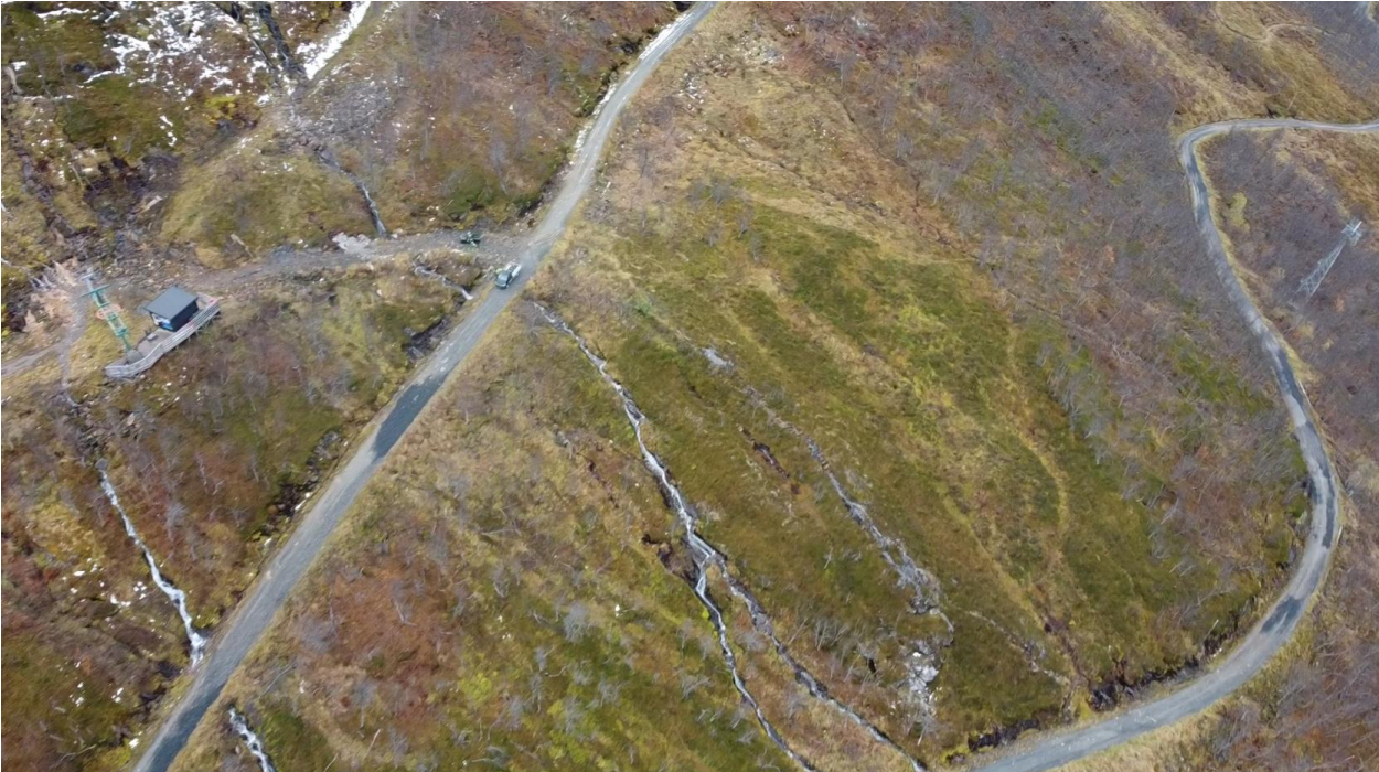
Bilde 3: Litt brattere parti nedenfor, hvor det kan løsne noe smått. Det er grunt til berg og lite løsmasser. Ser spor av tidligere bekkeløp. Sett motnordvest.
