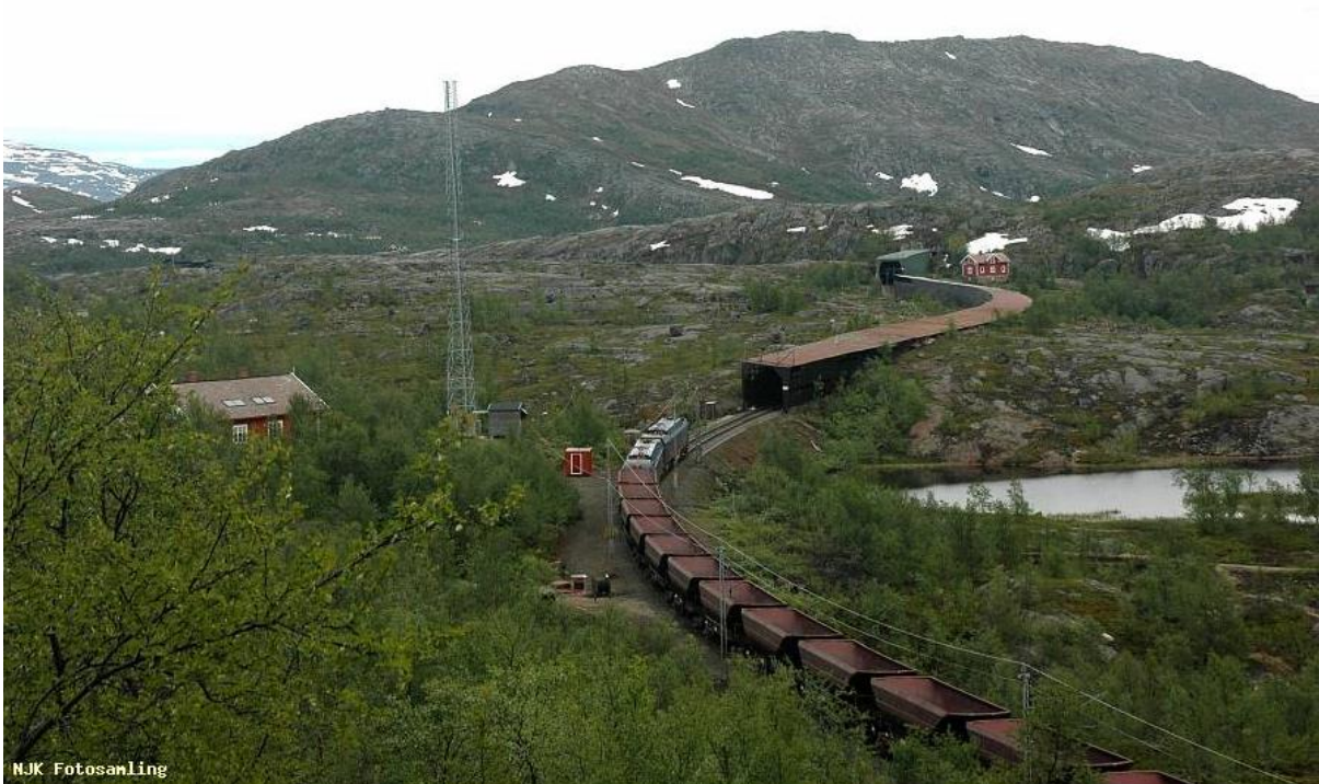
Figur 4.9: Tomt malmtog passerer Gamle Haugfjell stasjon, som ligger til venstre i bildet. Bygningen ved det grønne snøoverbygget er Nordstrømbrakka. Kilde: NKJ Fotosamling.
