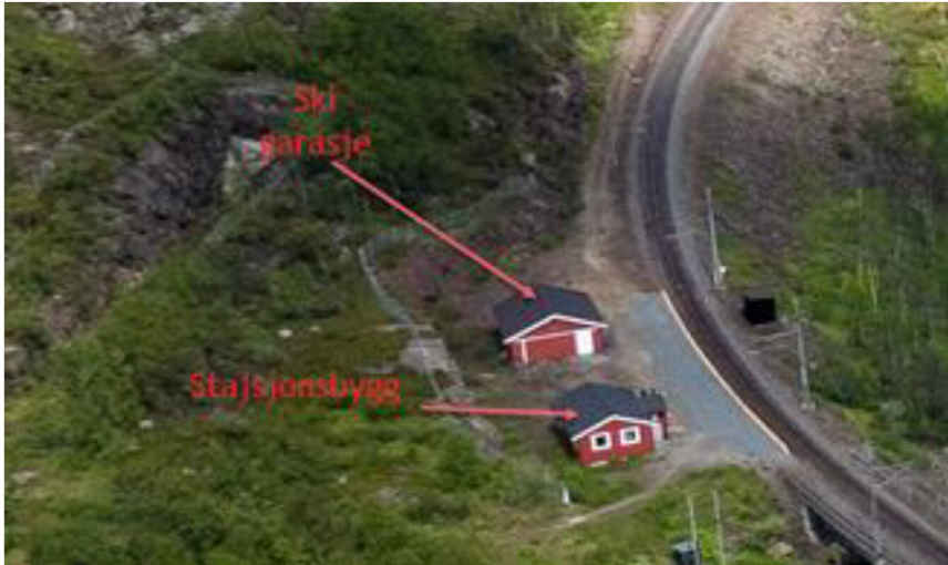
Figur 4.11: Bygninger på Søsterbekk holdeplass. Kilde: BaneNOR/Tobias Ekhorn Jenssen.
