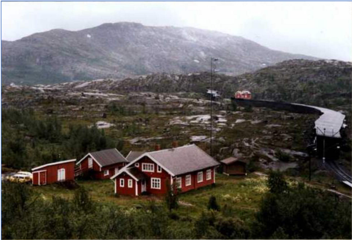
Figur 4.15: Gamle Haugfjell stasjonsbygning. Kilde: Gamlenarvik.no.
