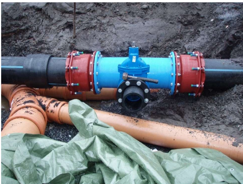
Figur 4 – Bilder fra anleggsgjennomføring ved etablering av nyanlegg til Rica/Scandic hotell Narvik
