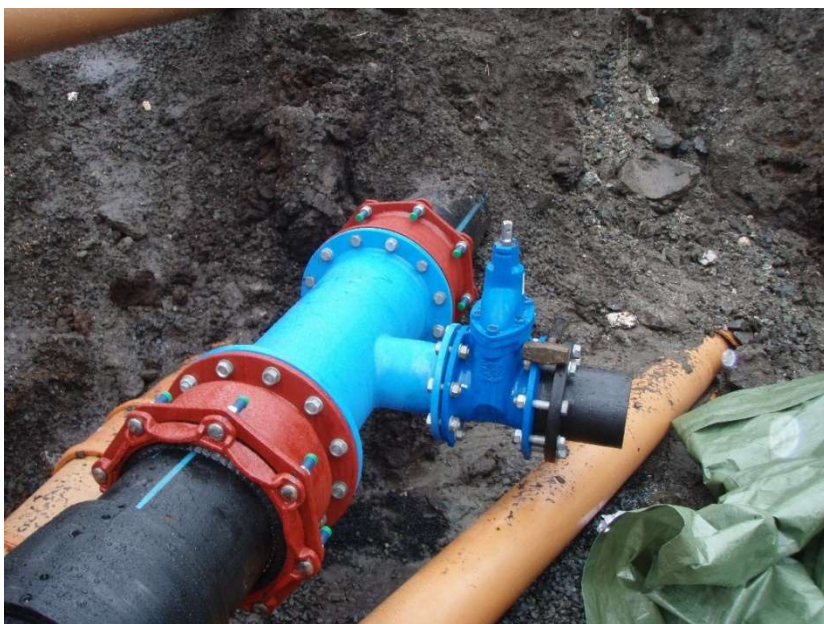
Figur 6 – Bilder fra anleggsgjennomføring ved etablering av nyanlegg til Rica/Scandic hotel Narvik
