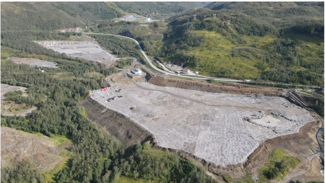
Figur 4-2: Dronefoto som viser utførte grunnarbeider ved Skoglund. Foto: Aker Narvik.
