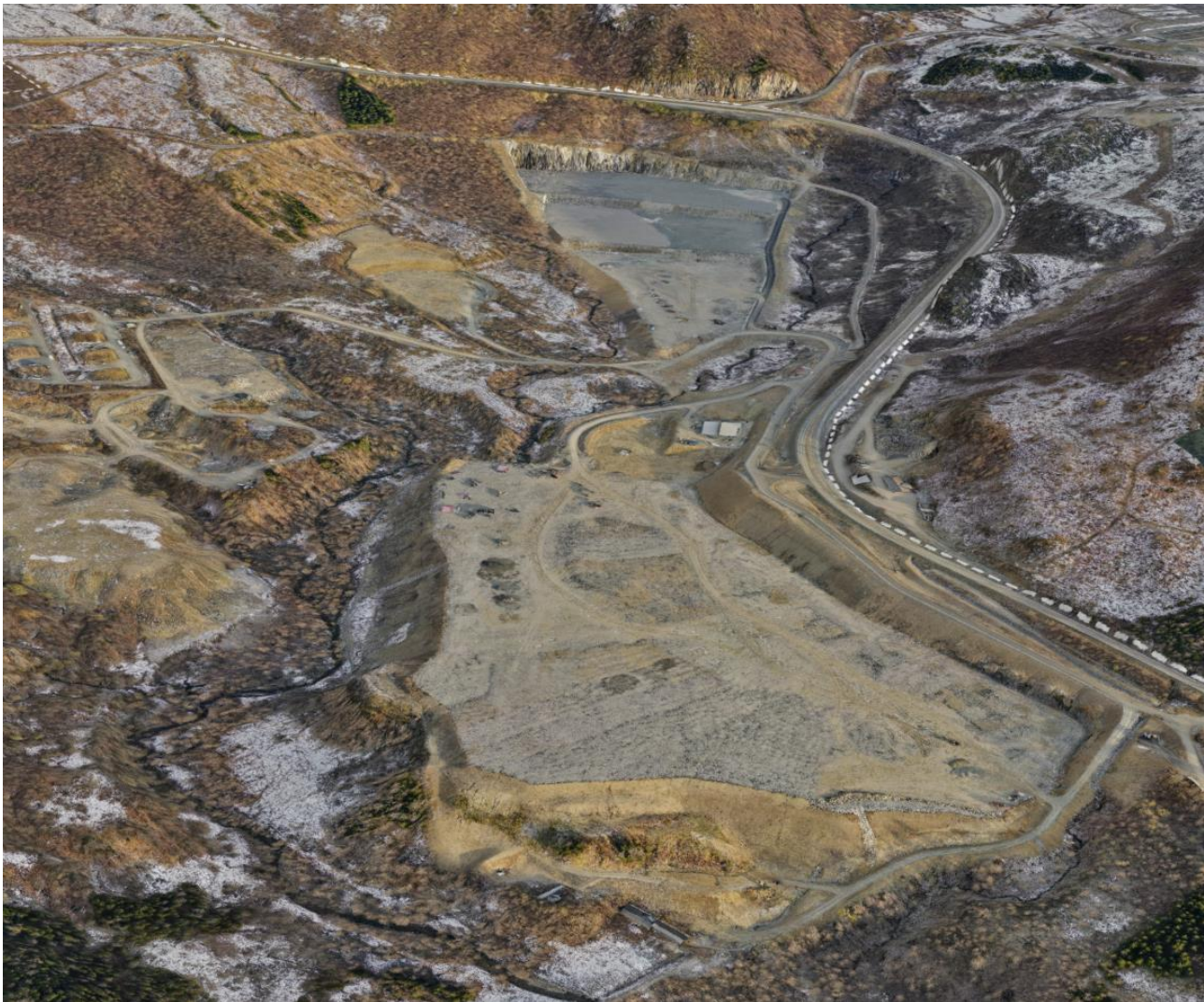
Figur 5-8: Flyfoto over Skoglund som viser gjennomførte grunnarbeider på områdene hvor det foreslås etablert ammoniakkanlegg, hydrogenanlegg og annen industri.
