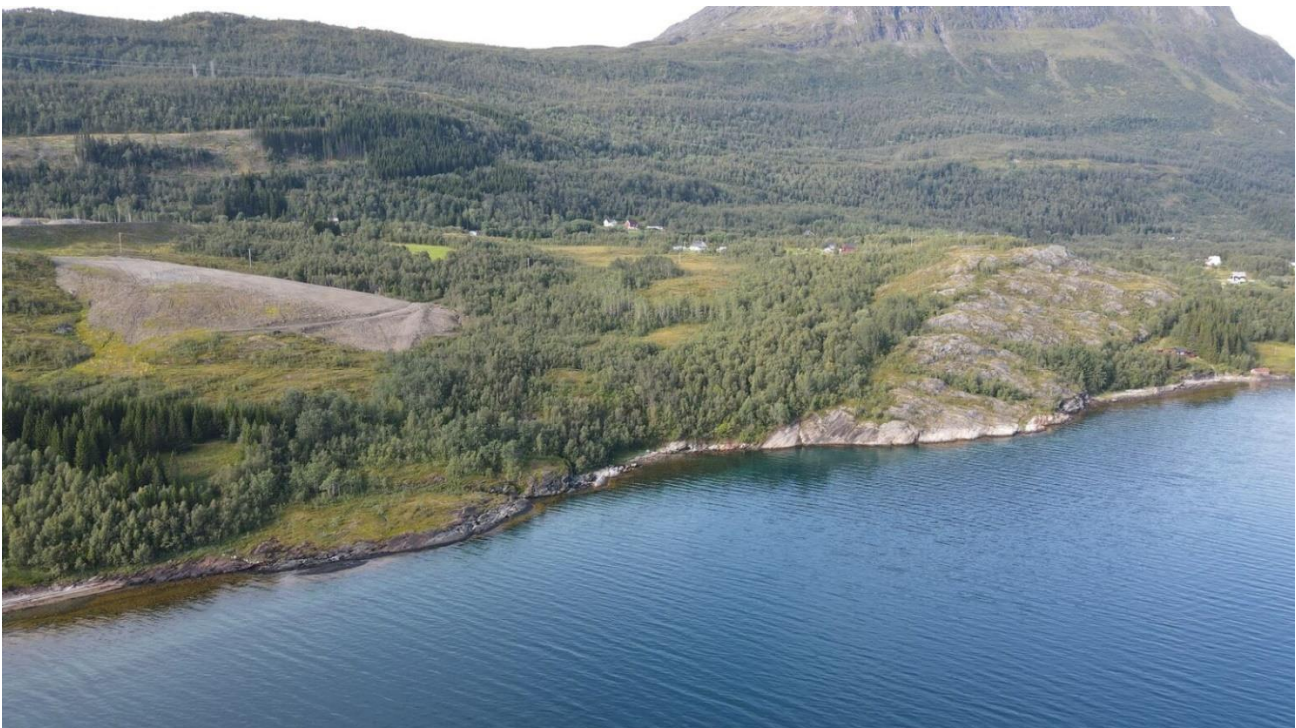
Figur 4-4: Dronefoto som viser nordre del av Lallasletta med eksisterende spredt boligbebyggelse i bakgrunnen. Foto: Aker Narvik.
