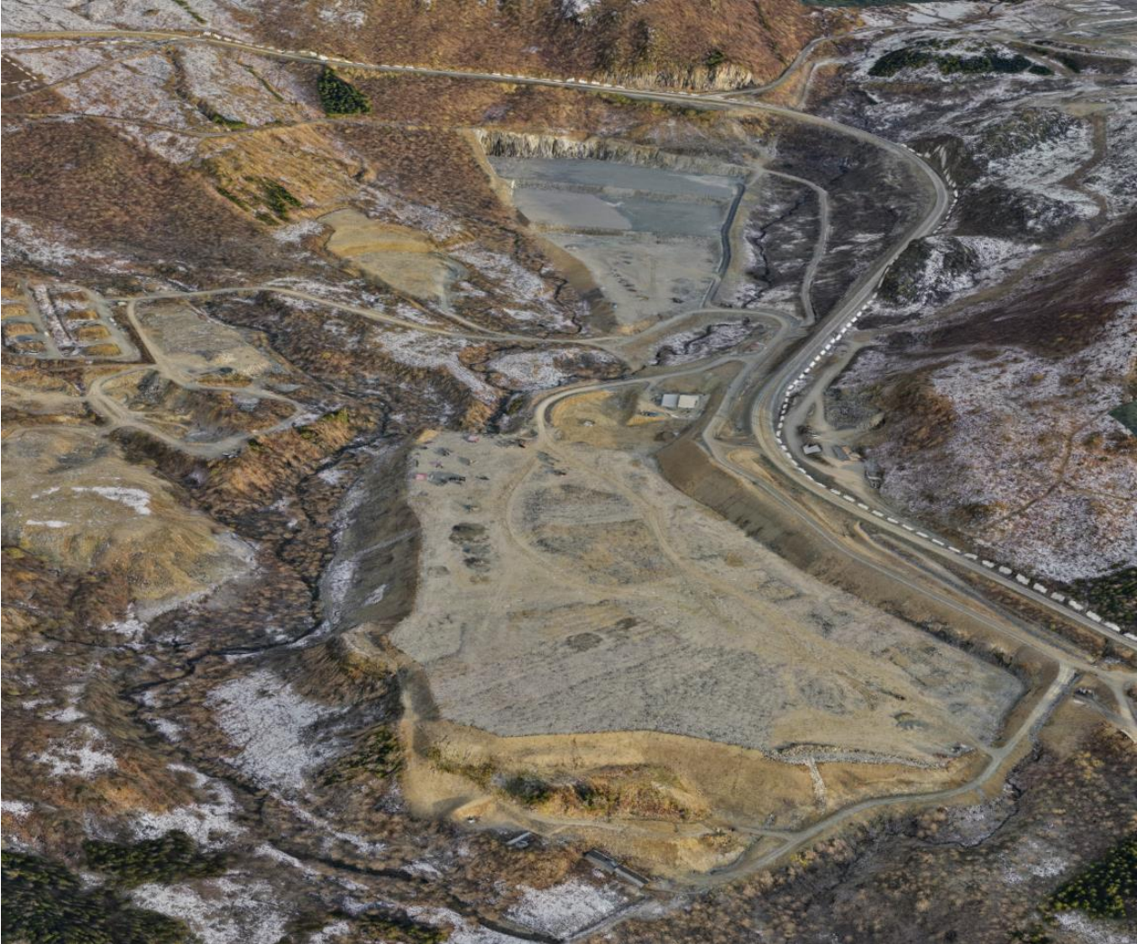
Figur 2-2: Flyfoto over Skoglund som viser gjennomførte grunnarbeider på områdene hvor det foreslås etablert hydrogenanlegg og annen industri.
