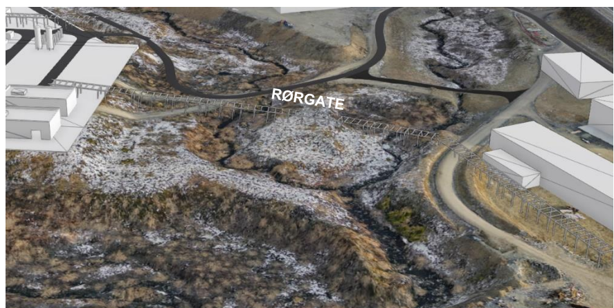
Figur 2-5: Rørgate mellom hydrogen- og ammoniakkanlegg
