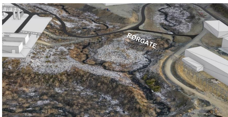
Figur 2-7: Rørgate mellom hydrogen- og ammoniakkanlegg
