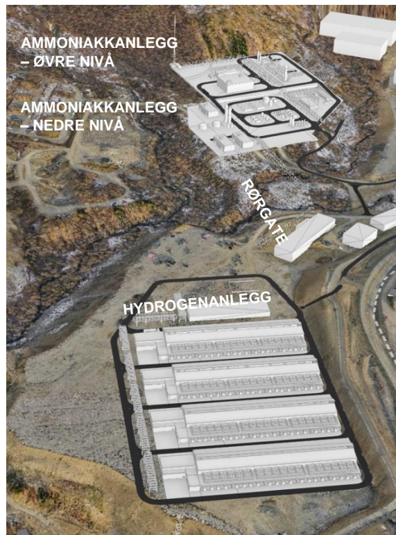
Figur 2-6: Areal for hydrogen- og ammoniakkproduksjon
