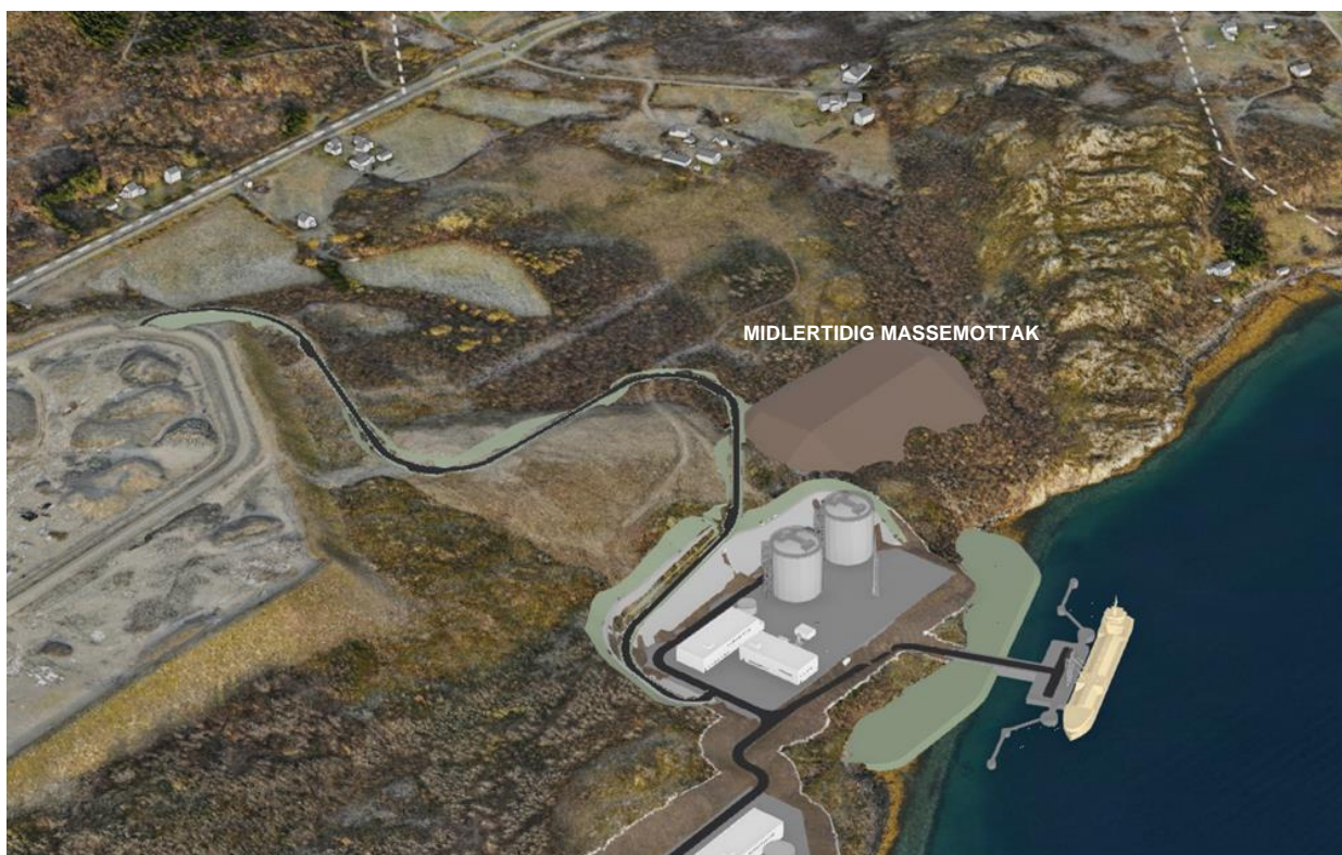
Figur 2-24: Midlertidig massemttak Lallasletta, oversiktsbilde
